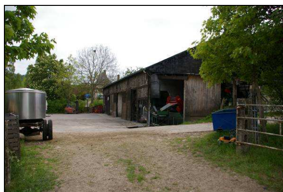
Bâtiments de transformation
